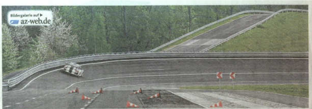
Es geht hoch hinaus: Die Steilkurve auf dem gestern offiziell eröffneten Aldenhoven Testing Center hat eine maximale Querneigung von 72 Prozent. Fotos: Harald Krömer
